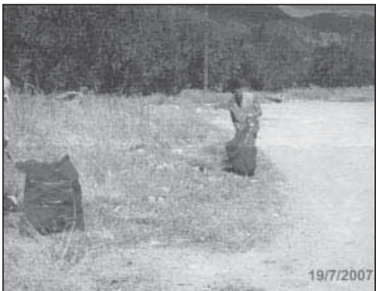
Δρόμος Αμφισσας-Ιτέας: Συνεργεία του εργολάβου καθαρίζουν προσεκτικά
